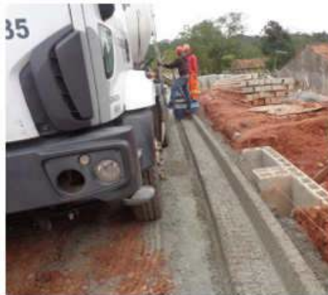
Figura 85 - Execução de guia e sarjeta com máquina extrusora
